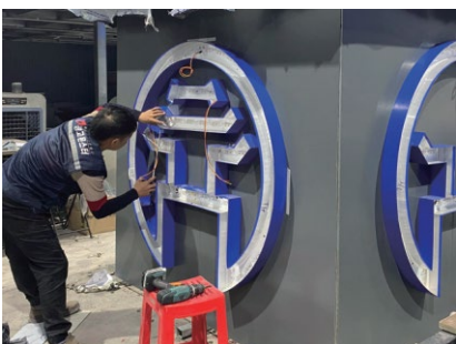
LED 부착 및 전선 작업
